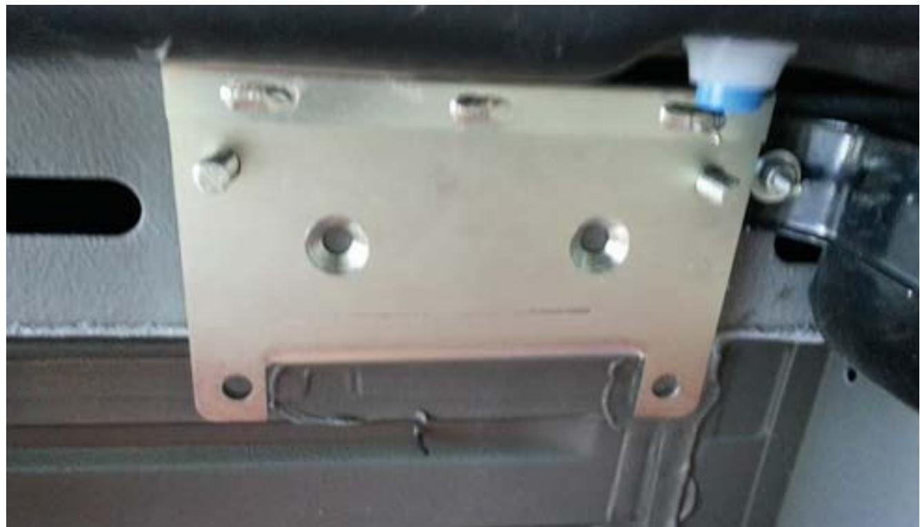
Bor to 10 mm huller efter den skabelon, der er dannet af støtten, som vist på billedet.
